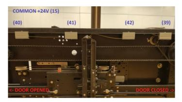
Verificare con un multimetro lo stato degli switch magnetici nelle posizioni indicate:
